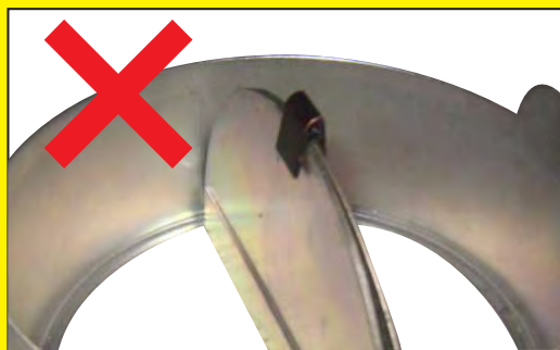
ヒューズ(作動後の金属)を折り曲げてはさむ
