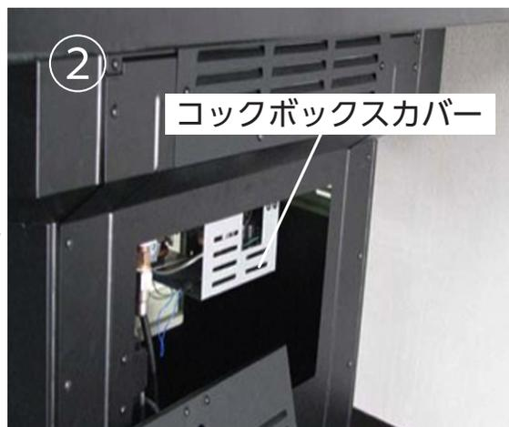
ルーバーを外した状態。コックボックスカバーが見えなければ反対側のルーバーを外す。
