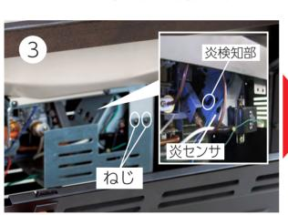
写真の2箇所のねじを外すとコックボックスカバーが外せます。炎検知部の汚れは、綿棒や柔らかい濡れ雑巾などで、表面をきれいにしてください。作業が終わりましたら、コックボックスカバーを復旧してください。
